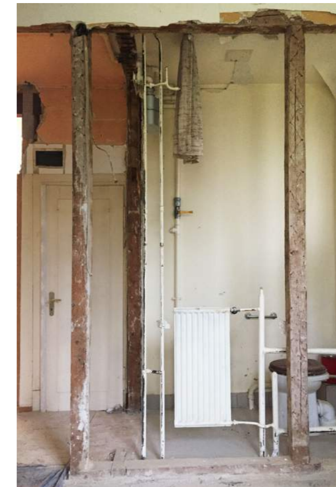
Abbruch von Wandteilen und Herstellung der neuen Bodenplatte für den Anbau (2021).
