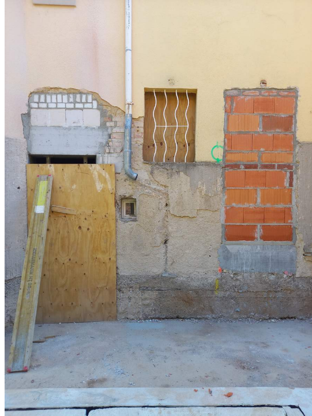
Durchbrüche für den neuen Eingang ins Bestandsgebäude (2021).
