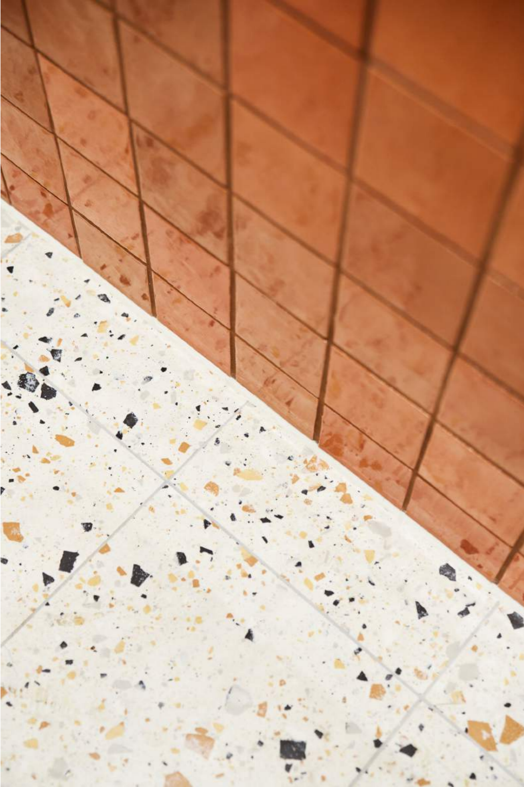
Fliesen in den Toiletten im Untergeschoss.
